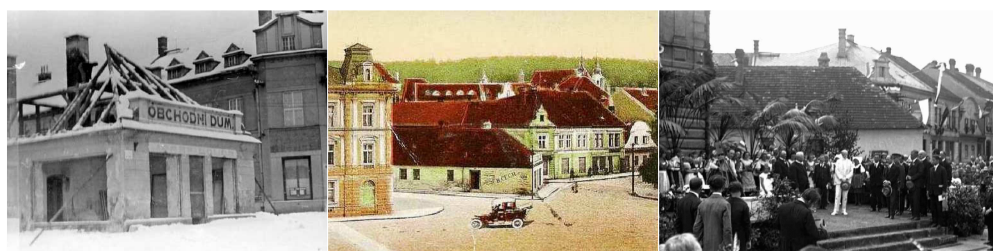
dům č.p. 71 byl zbořen kolem roku 1970
